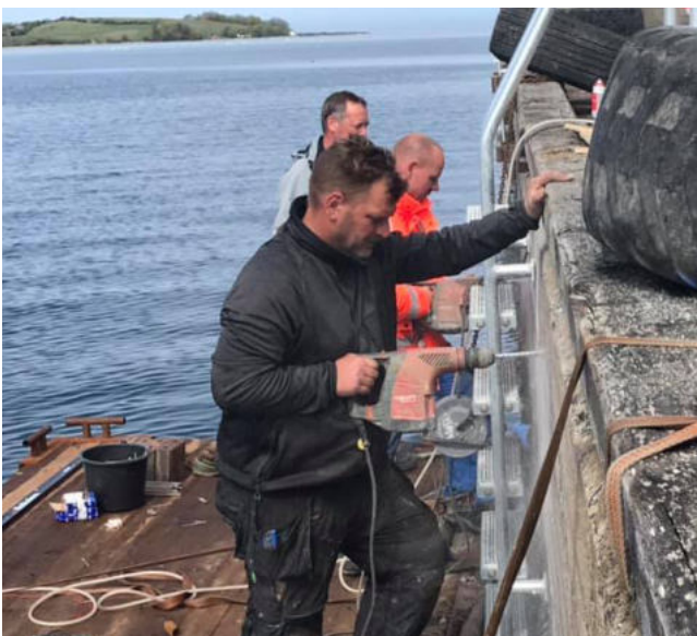
Der arbejdes på Havnsø Havnebad 2019. Foto: Kristian Kallenbach.
